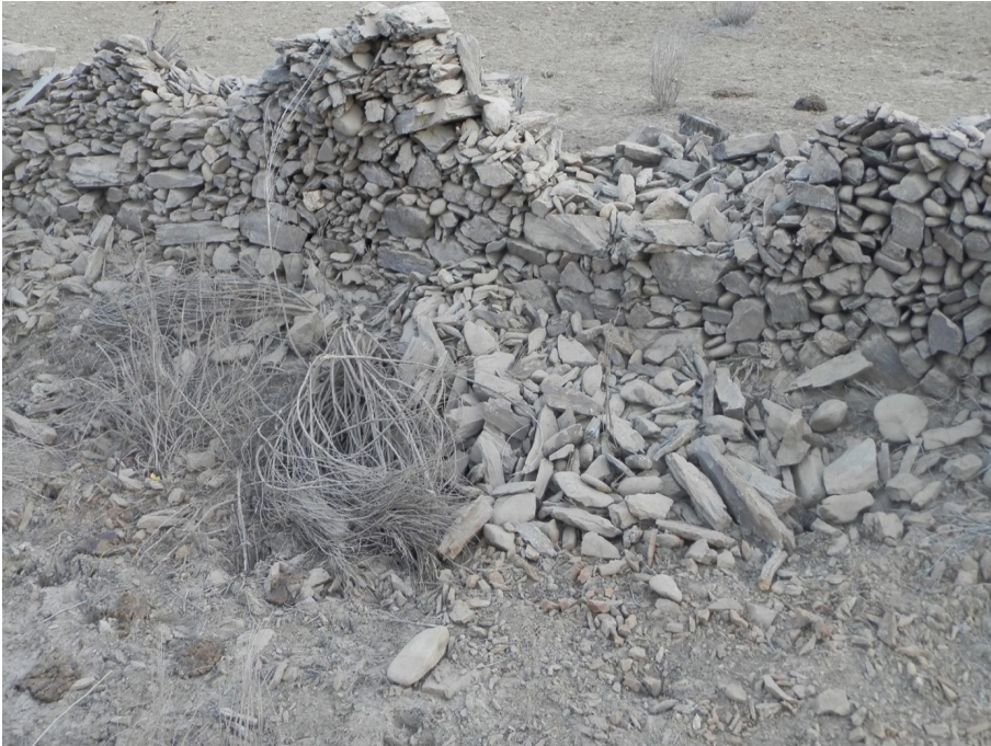
Photographie 7 : Muret abandonné sur le site du nouveau barrage
